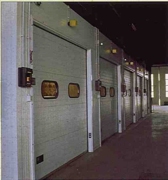
Celle con porte a scorrimento interno Cold rooms with internal lifting doors Chambres froides avec portes à coulement interne Bananenlagerzellen mit innen liegender Schiebetür
